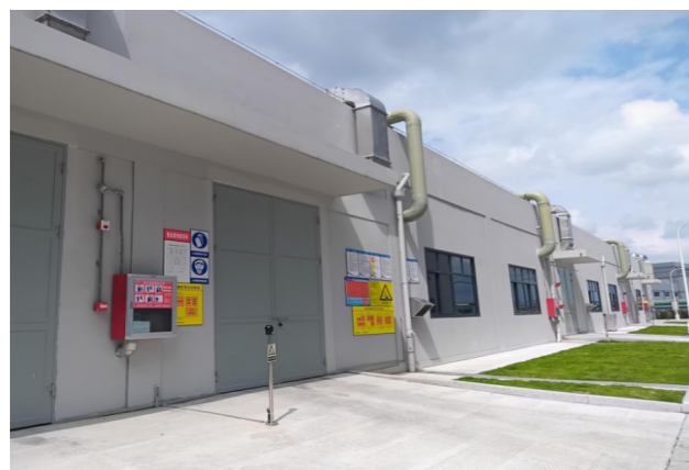
危险废物仓库
